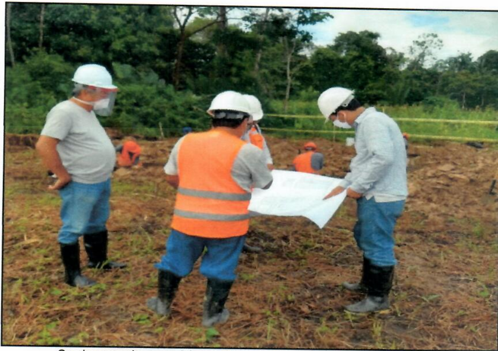
Se observa a la supervision verificando el trazo y replanteo del proyecto
