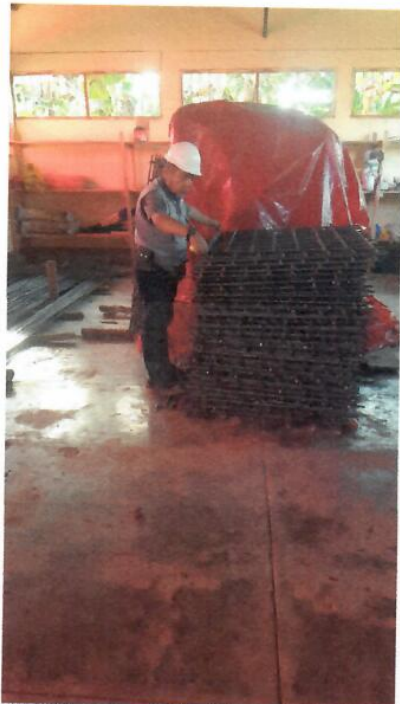
Se observa al Residente de obra verificando dimensiones de acero acondicionado en almacen
