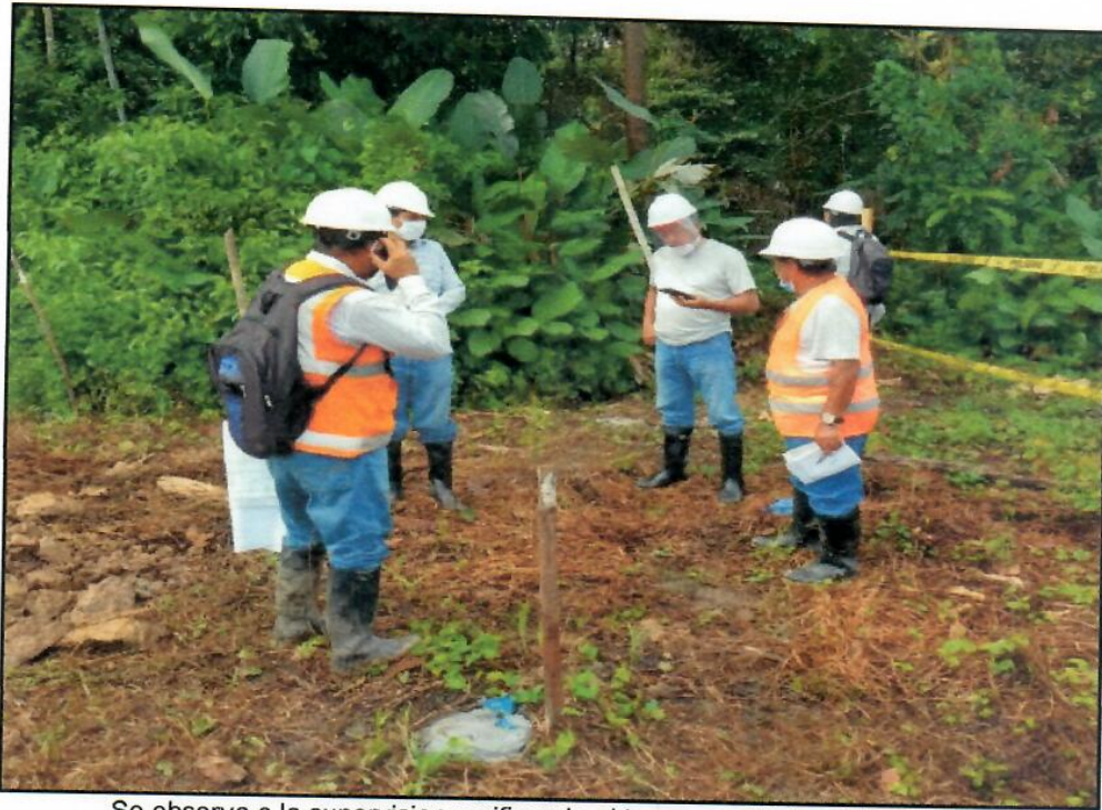
Se observa a la supervision verificando el trazo y replanteo del proyecto
