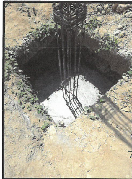
FOTO N° 04: ZAPATA Z-1 VACIADA Y COLUMNA C-1 MODULO 1 EJE 7-C
