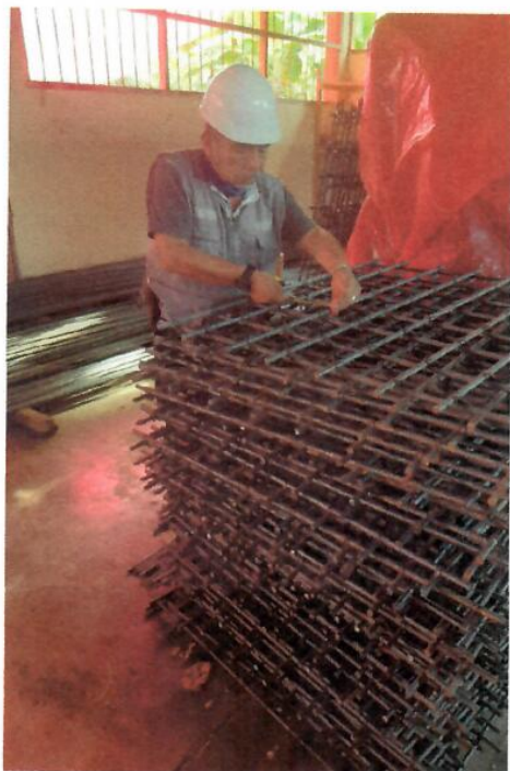
Se observa al Residente de obra verificando dimensiones de acero acondicionado en almacen
