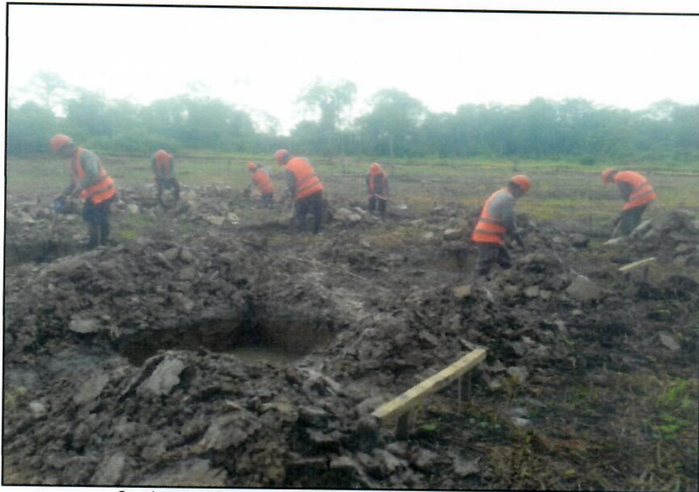
Se observa el proceso de Excavacion de Zapatas del proyecto
