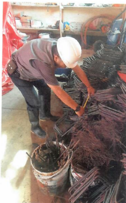
Se observa al Residente de obra verificando dimensiones de acero acondicionado en almacen
