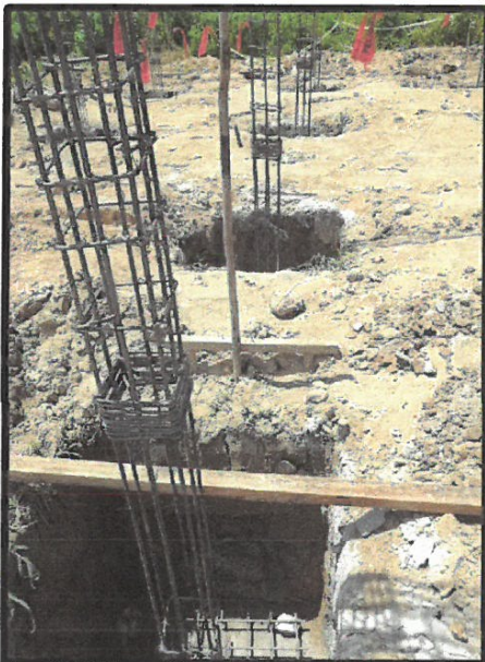
FOTO N° 03: ACERO EN ZAPATA Z-1 Y COLUMNA C-1 EN MODULO 1 EJE B
