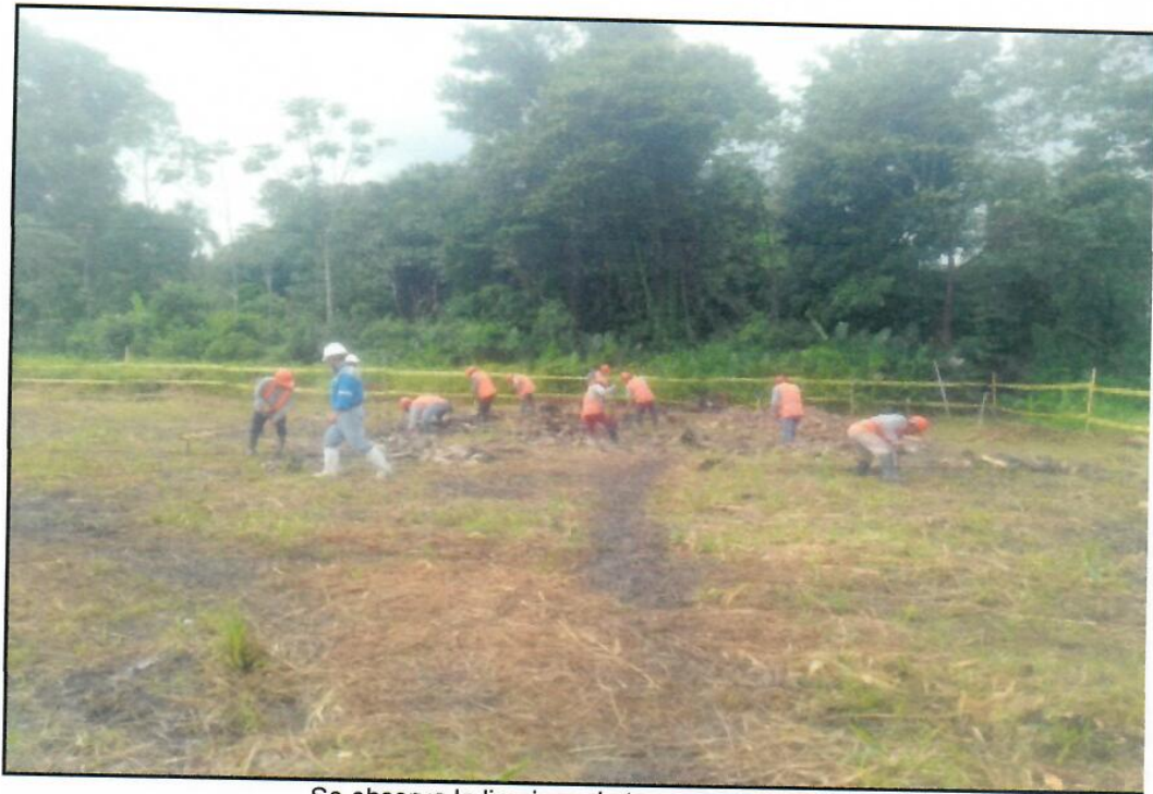
Se observa la limpieza de terreno manual
