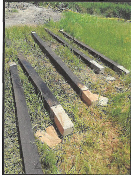
FOTO N° 08: PILOTES DE MADERA DE 5 M PREVIO A SU HINCADO EN EL MODULO 4
