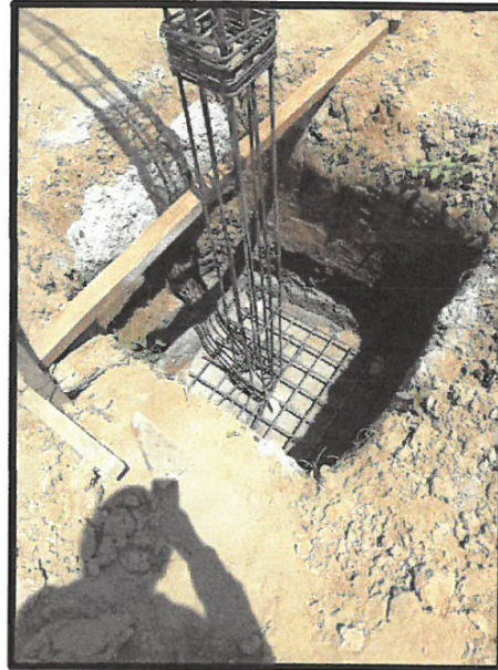
FOTO N° 02: ACERO EN ZAPATA Z-1 Y COLUMNA C-1 EN MODULO 1
