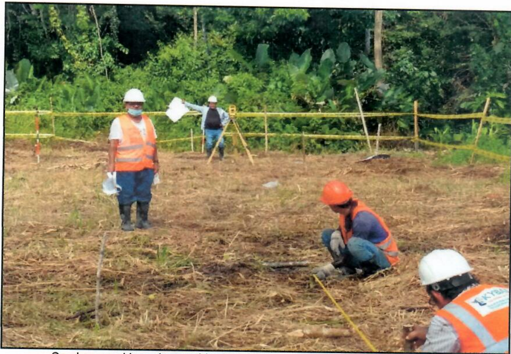
Se observa al ingeniero residente en el procedimiento de trazo y replanteo
