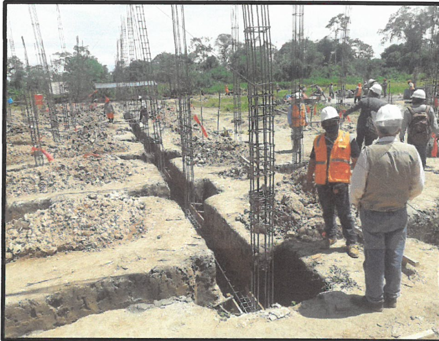
FOTO N° 05: EXCAVACION DE VIGA DE CIMENTACION EJE A CON ACERO POSICIONADO
