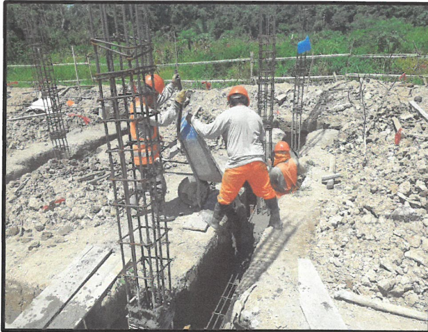
FOTO N° 11: VACIADO DE VIGA DE CIMENTACION EN MODULO 3 EJE 8
