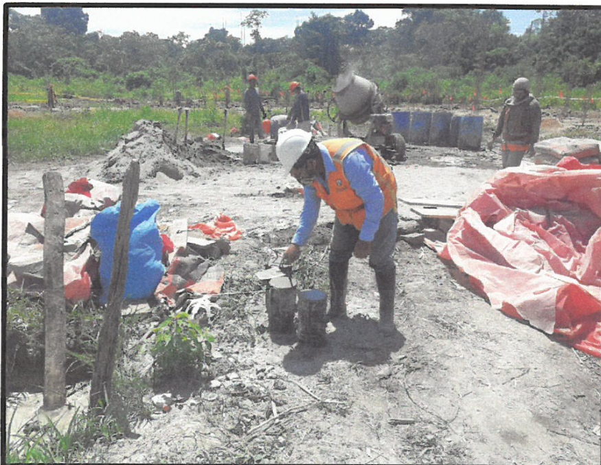
FOTO N° 12: MAESTRO DE OBRA PREPARANDO LOS TESTIGOS DEL VACIADO DE VIGA DE CIMENTACION
