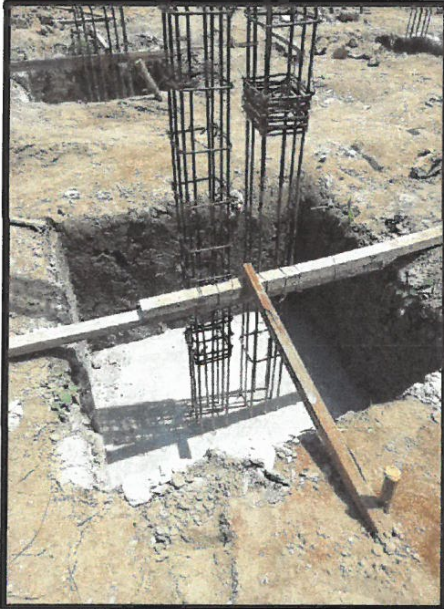
FOTO N° 01: VACIADO DE ZAPATA Z-2 EN MODULO 2 EJE 9-B
