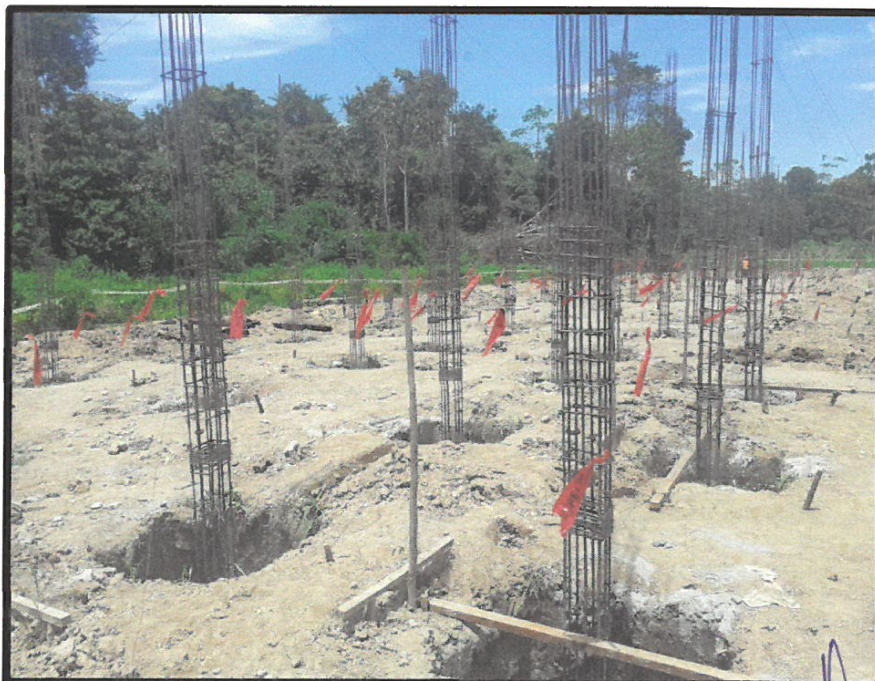
FOTO N° 06: MODULO 2 CON TODO EL ACERO DE LAS COLUMNAS C-1 POSICIONADO
