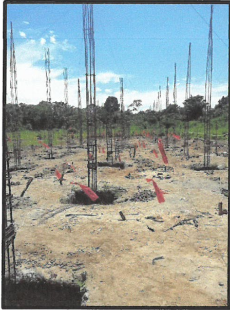
FOTO N° 07: MODULO 2 CON TODO EL ACERO DE LAS COLUMNAS C-1 POSICIONADO VISTA GENERAL
