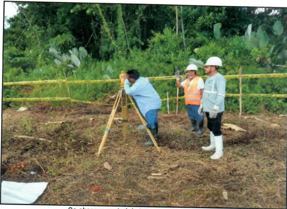
Se observa control de trazo y replanteo en obra
